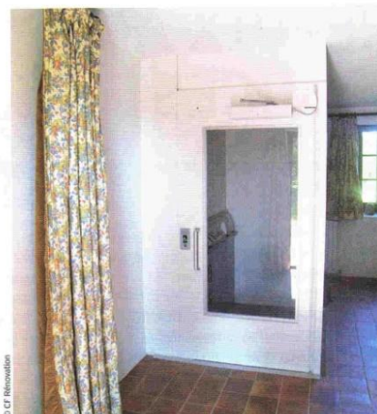
L'installation d'un ascenseur implique le partenariat avec un maçon.
